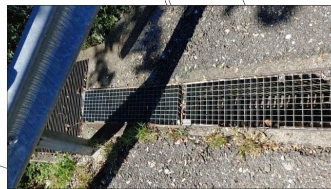
Rimozione e sostituzione canaletta Entfernen und Neueinbau Straßenrinne
