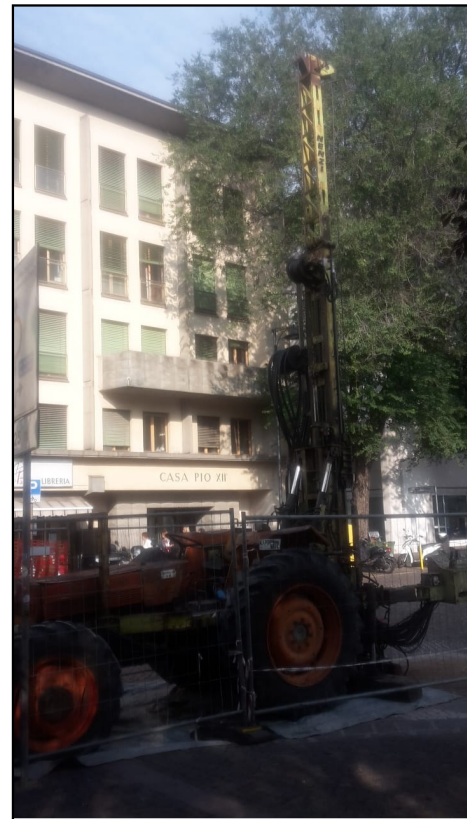
SONDAGGIO - BOHRUNG: S3/18
