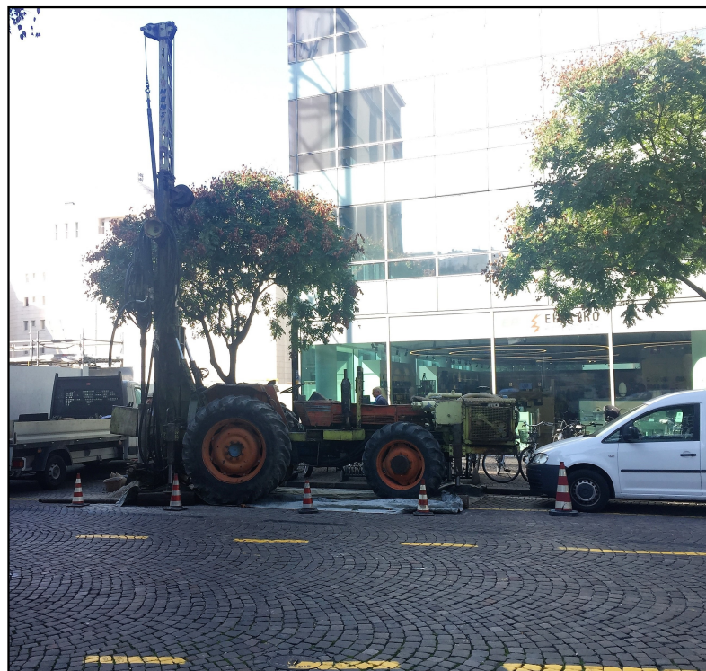
SONDAGGIO - BOHRUNG: S2/18
