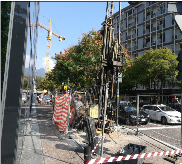
SONDAGGIO - BOHRUNG: S1/18
