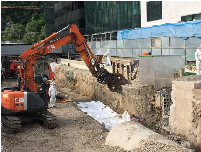
Teglio e allontanamento della polifora Telecom con tubi in fibro-amianto
