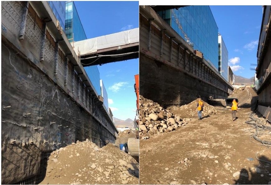
Scavo per porzioni lungo la parete chiodata ovest
