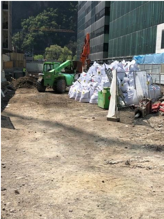
Operazioni di confinamento e insaccamento del terreno con amianto
