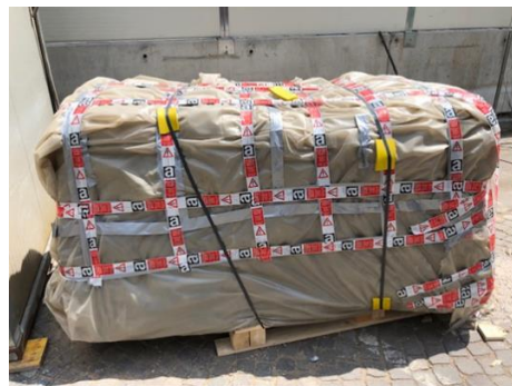
Teglio e allontanamento della polifora Telecom con tubi in fibro-amianto
