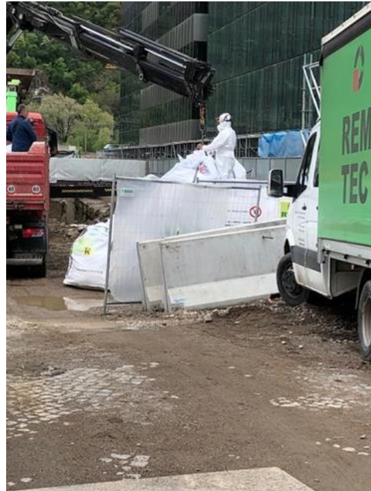
Operazioni di confinamento e insaccamento del terreno con amianto
