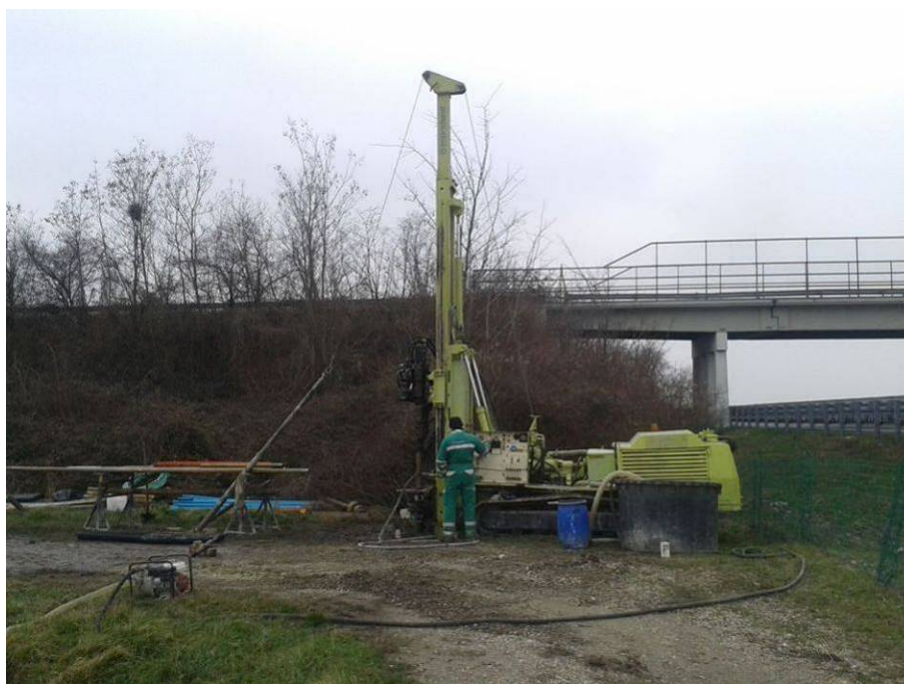
Figura 10 – Esempio di sondaggio geognostico.
