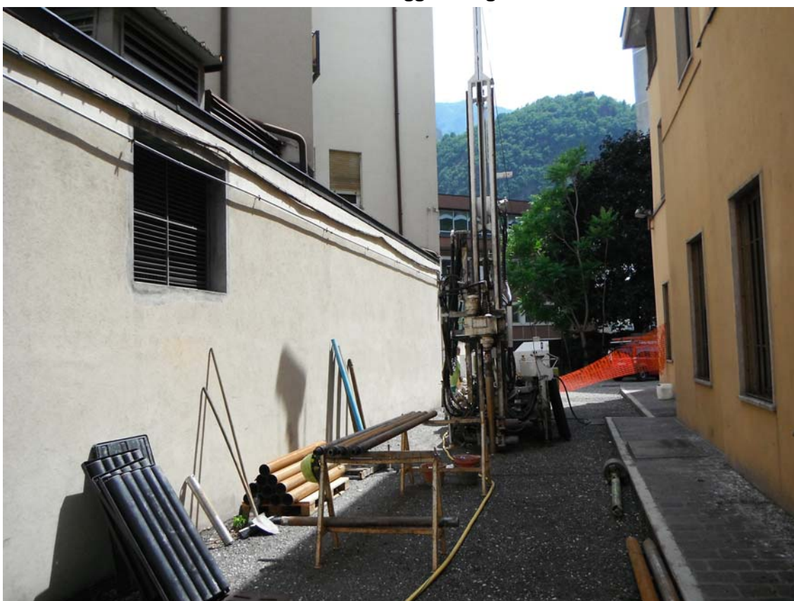
Postazione Sondaggio Geognostico
